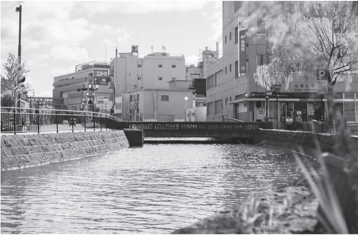
七尾の中心市街地を東西に分ける「御碓川」。地震による地盤沈下で水位が上昇しているように見える
