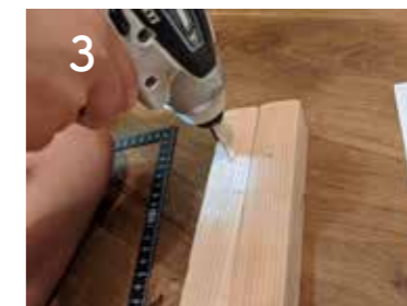
3 ビスをうつ位置に鉛筆で目印をして、まずは下穴。
