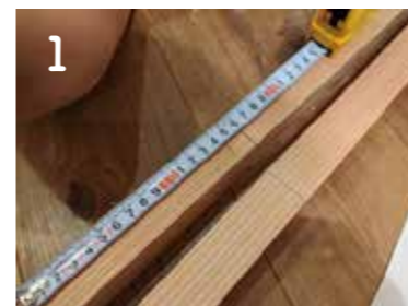
1 部材を取り付ける位置に、差し金で正確に線を引く。
